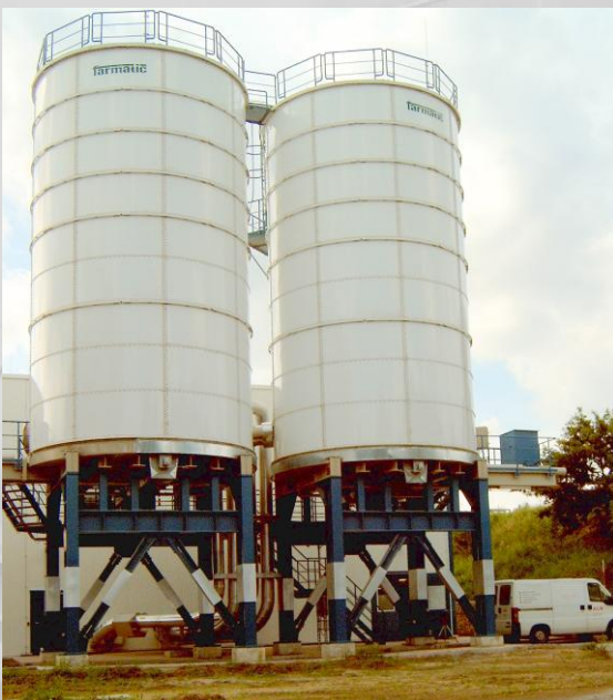
Verwiegung von 400t – Klärschlammsilos mit zusätzlicher Isolierung
